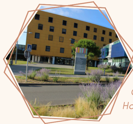
EHPAD La Vannerie
